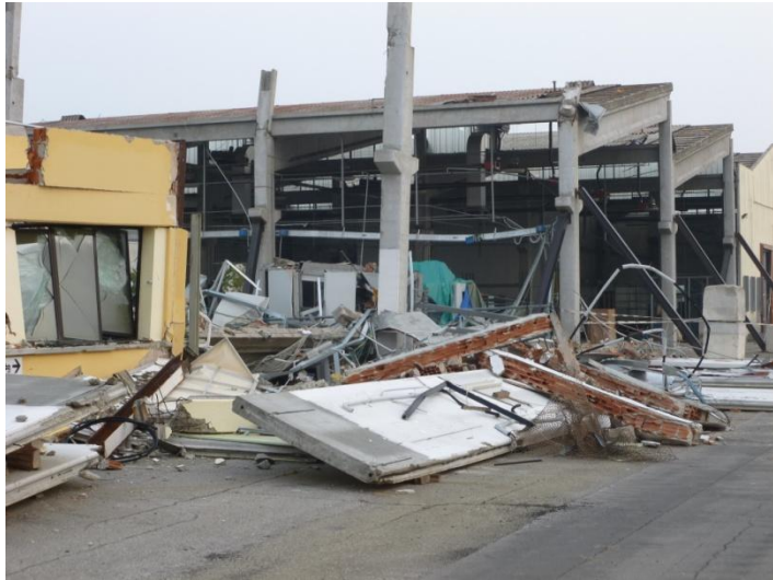
Capannone artigianale crollato (Medolla)
